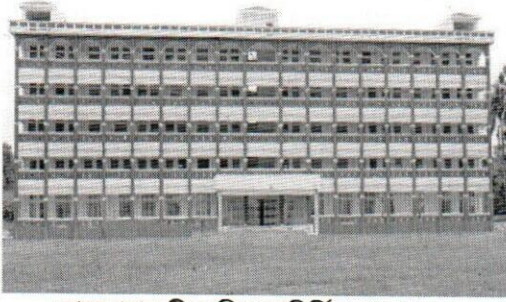
হোসেনাবাদ টিএসসির নবনির্মিত ৫তলা ভবন
